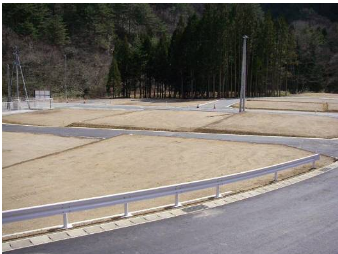
【写真左】造成工事が完了した松前沢地区
